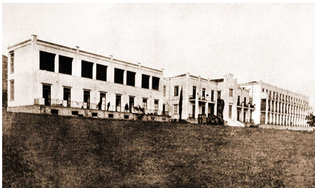
Fig.24. Foto storica antecedente al 1935, da sinistra corpi 4, 3, 2, fronte Est
