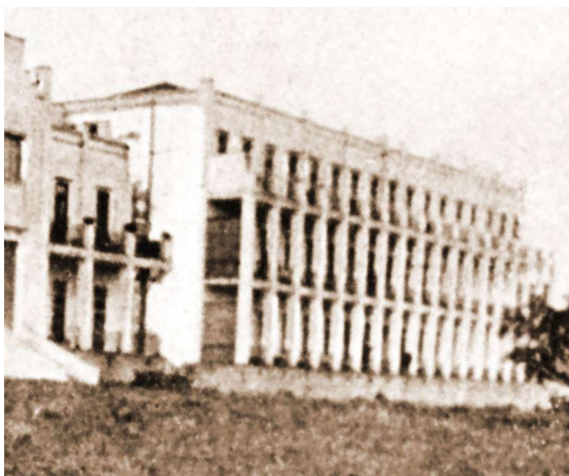
Fig.17. Particolare del fronte Est del corpo 2 (ex padiglione donne) nella configurazione originaria
