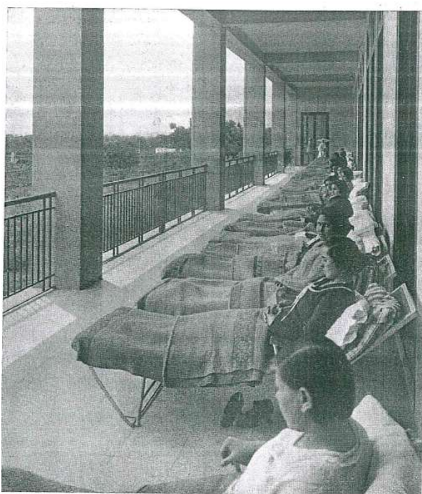
Fig.15. Veranda di cura, corpo 2 Padiglione B.
