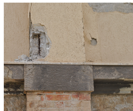
Fig.13.Fronte Est: a) indicazione di alcuni elementi in c.a.; b) particolare di armatura in elementi in c.a.
