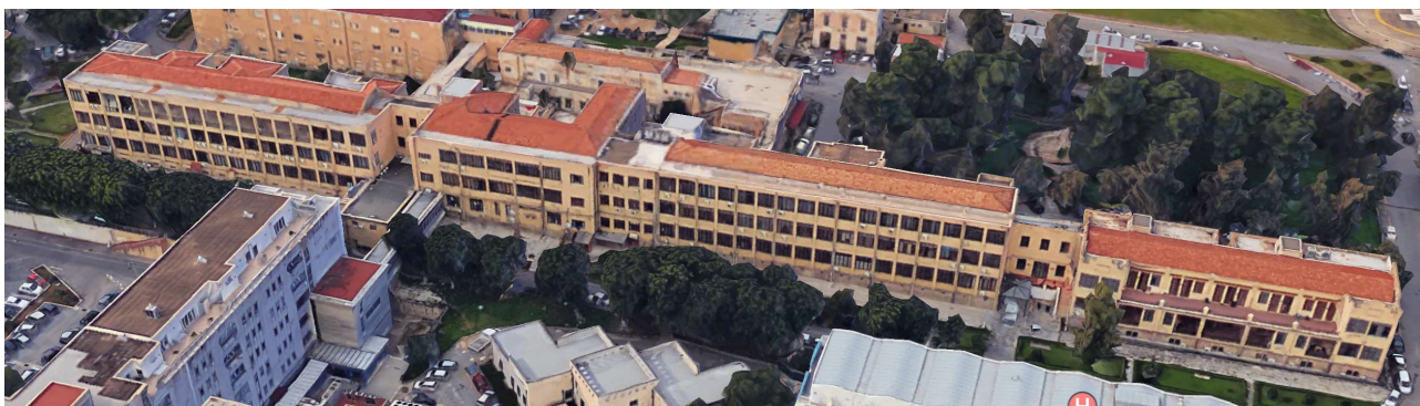
Fig. 8. Prospetti dei corpi (da sinistra) 4, 3, 2, 1 – immagine Google Maps ripresa da Est.
