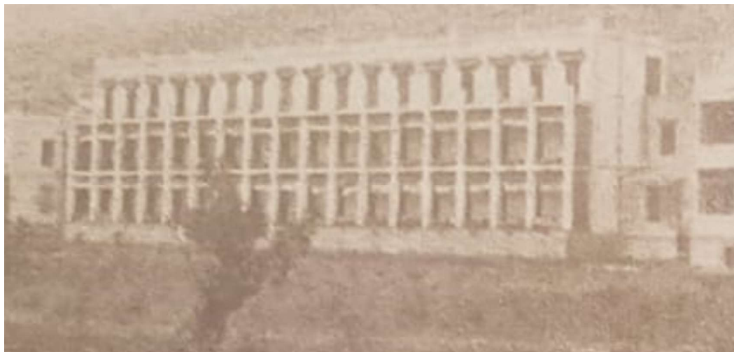
Fig.16. Particolare del fronte Est del corpo 2 (ex padiglione donne) nella configurazione originaria
