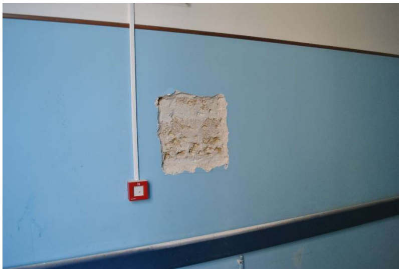
Fig.18. Muratura rilevata da rimozione di intonaco al piano 3.
