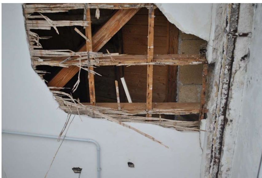
Fig.21. Particolare del solaio di copertura visibile attraverso controsoffitto al piano 3.
