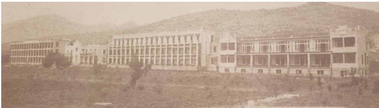
Fig.7. Prospetti dei corpi (da sinistra) 4, 3, 2, 1 – immagine storica ripresa da Est.
