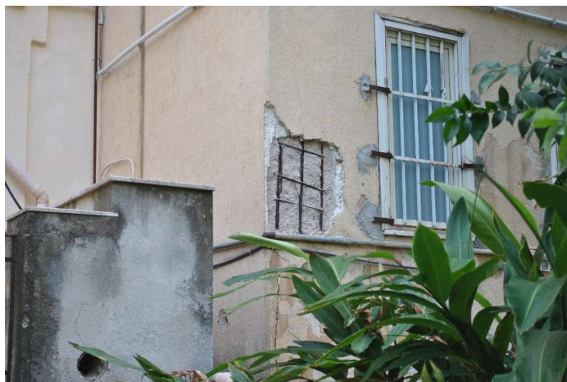
Fig.19. Pilastro in c.a., prospetto Ovest.
