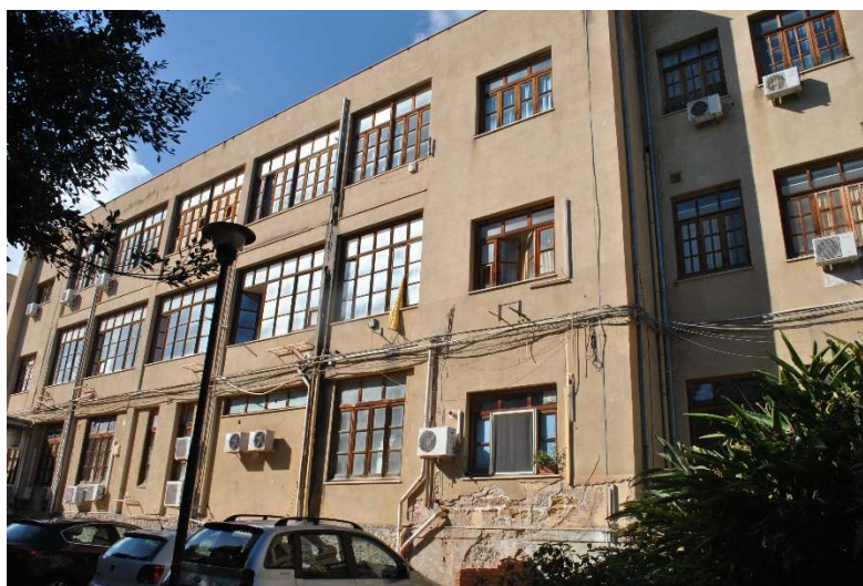
Fig.23. Foto attuale corpo 3, fronte Est.
